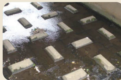
床止工(護床工)
